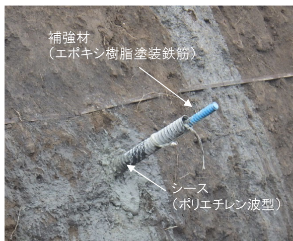
図-3 受圧板設置前の補強材とシース
