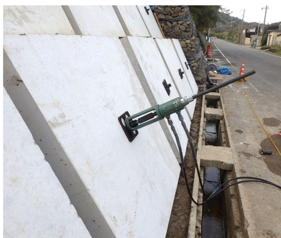
図-2 センターホールジャッキで緊張中
