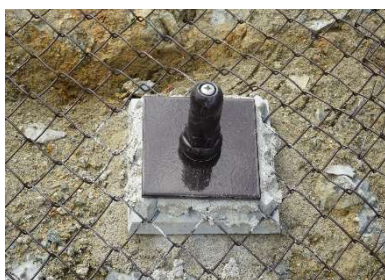
設置法 3（土砂地盤の場合）
