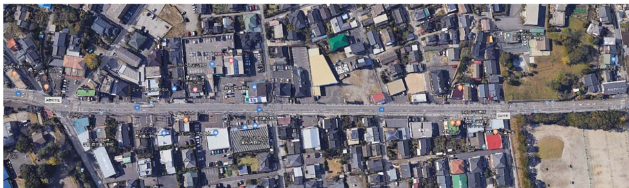
図-4.3 県道 16 号 吉野町帯迫付近 (Google Earth)
